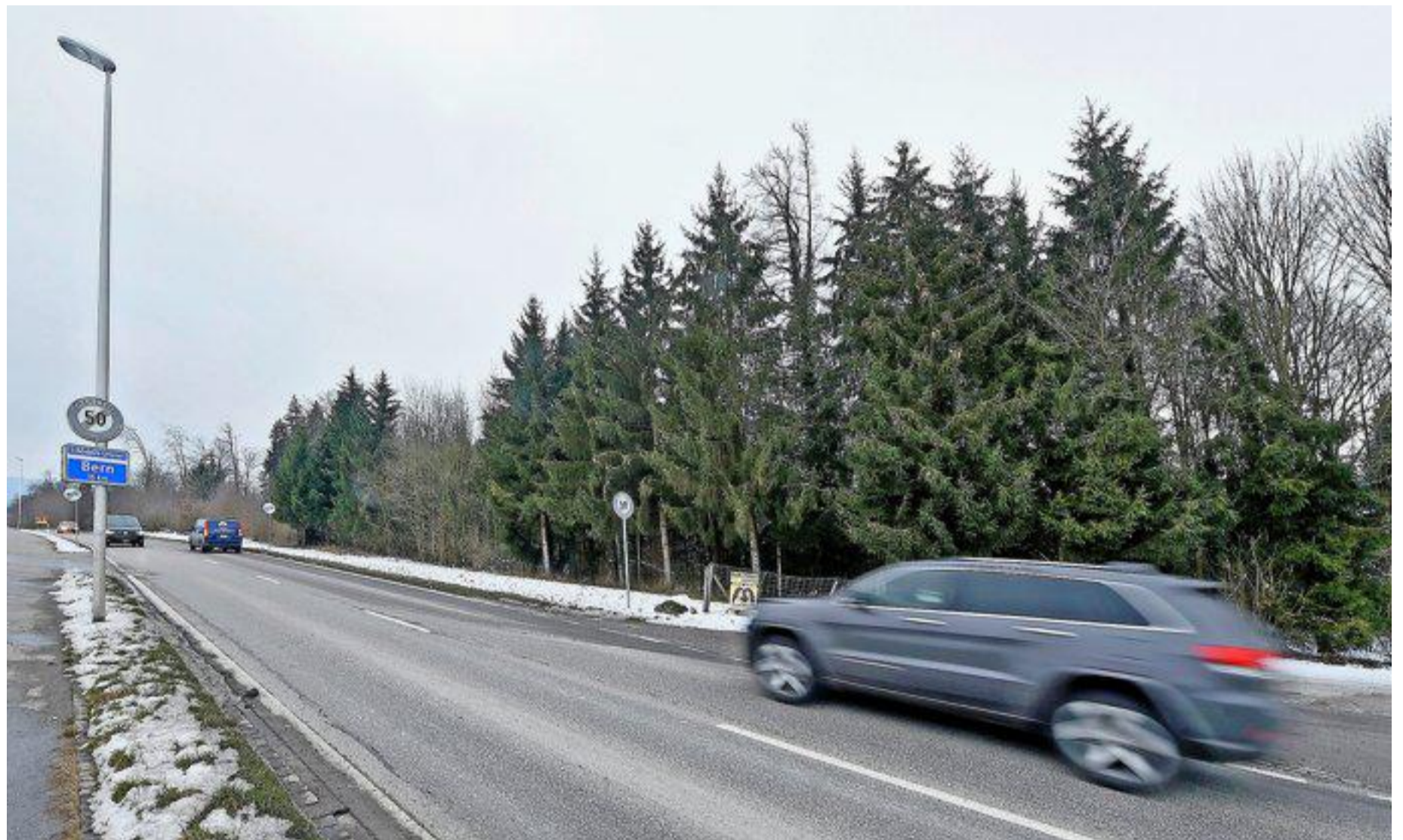
Heiss begehrt: Um das Kiesvorkommen unter dem Oberhardwald wird seit langem gestritten.
