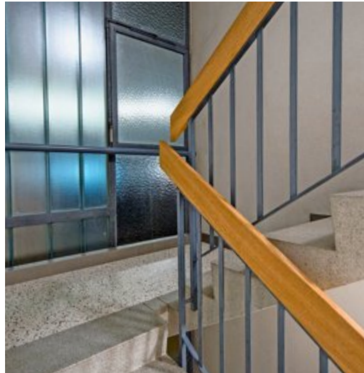
Ein Blick ins Innere: Eines der alten Treppenhäuser.
