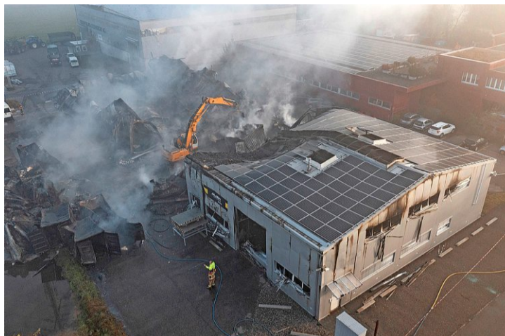
Ein Lagergebäude in Utzenstorf brannte am Sonntagabend nieder. Bis tief in die Nacht kämpfte die Feuerwehr gegen die Flammen. Foto: bm
