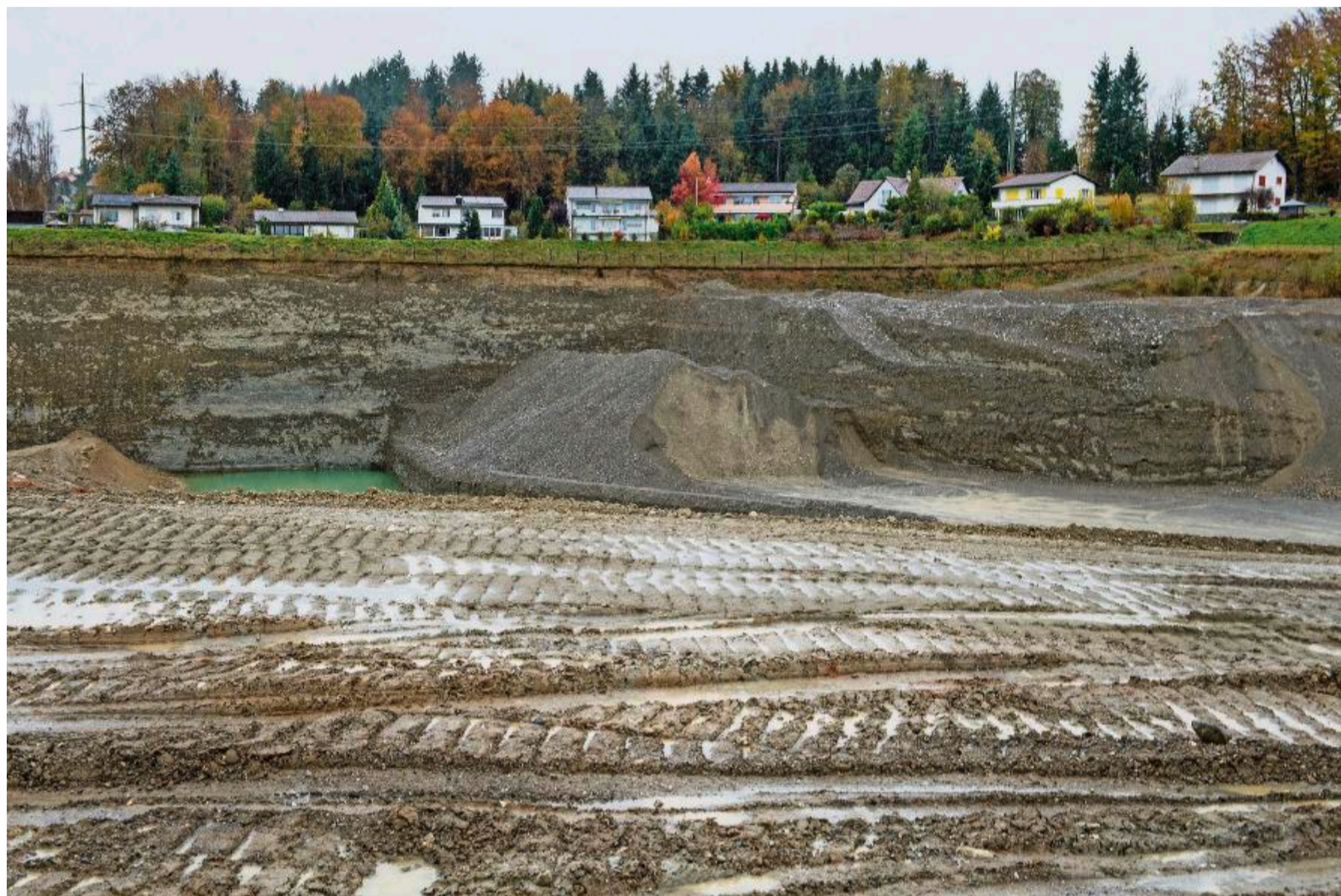
Kiesgrube Rubigen: Gemäss kantonaler Baudirektion hat die Firma Kästli hier unrechtmässig Kies abgebaut. Foto: Adrian Moser
